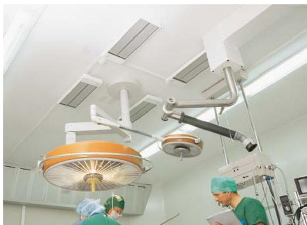
Le chauffage assuré par l'EZ200 est hygiénique, le système ne provoquant aucun déplacement d'air.
