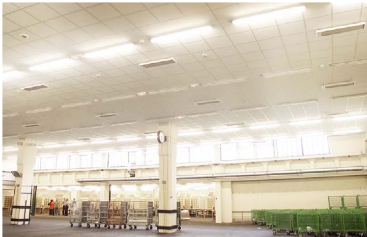
Los paneles radiantes dirigen el calor hacia las personas, el suelo y el mobiliario, proporcionando un alto grado de confort incluso en estancias muy grandes.
