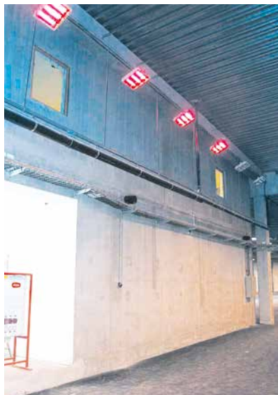
De IRCF kan aan de wand of aan het plafond worden gemonteerd en is geschikt voor gebouwen die sporadisch worden gebruikt, zoals deze startzone van een kartbaan.
