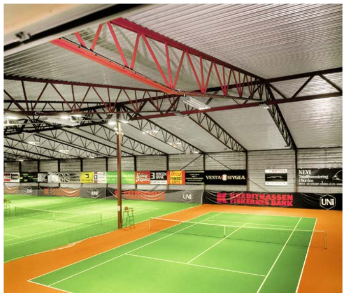
Podział dużej hali na różne strefy umożliwia duże oszczędności energii, zwłaszcza w budynkach, gdzie poszczególne strefy są używane sporadycznie. Można zastosować kratkę ochronną IRG, dostępną jako wyposażenie dodatkowe, aby zabezpieczyć promiennik, na przykład w ośrodkach sportowych.
