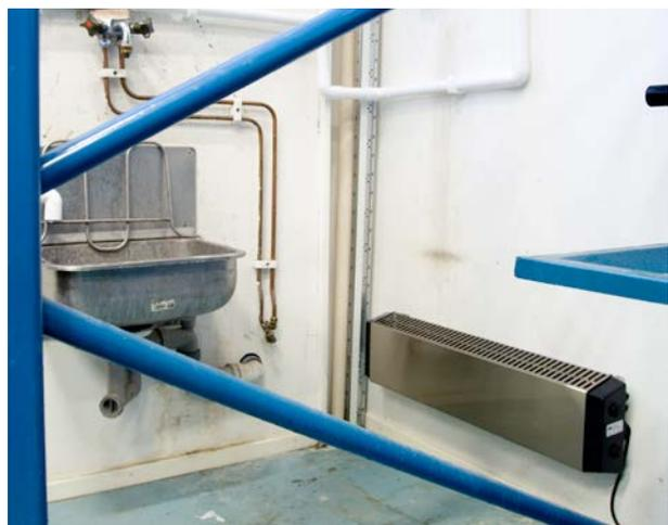
En el diseño de acero inoxidable, Thermowarm resiste entornos corrosivos.
