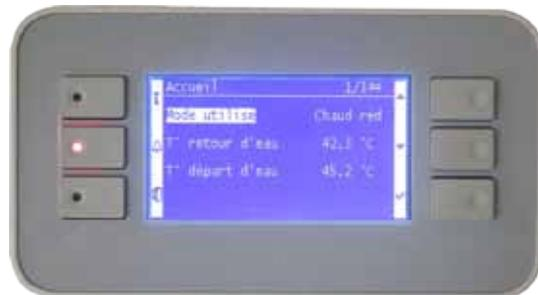
Die Kaltwassersätze SYSAQUA 20-125 L/H sind mit einer intelligenten Mikroprozessorsteuerung mit einer neuen IHM-Logik ausgestattet, die auf der Grundlage der Vorlauf- oder der Rücklaufwassertemperatur den Bedarf im Voraus berechnet.
