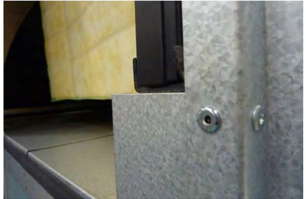
Comprobar que los perfiles de goma del panel posterior, así como los perfiles de goma de la puerta de inspección, no presenten desgaste ni daños, de modo que continúen en condiciones de evitar fugas de aire.
