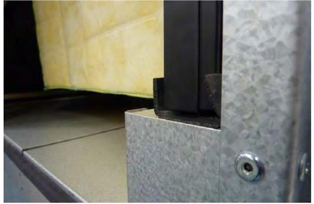
El extremo del último filtro está totalmente uniforme con el extremo del perfil en U. El perfil de goma de la puerta de inspección cierra la brecha entre la puerta de inspección y el filtro. Trabajo realizado.
