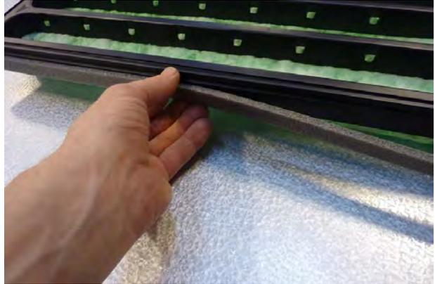
Compruebe que el extremo de la tira quede totalmente uniforme con el lado horizontal del bastidor del filtro.
