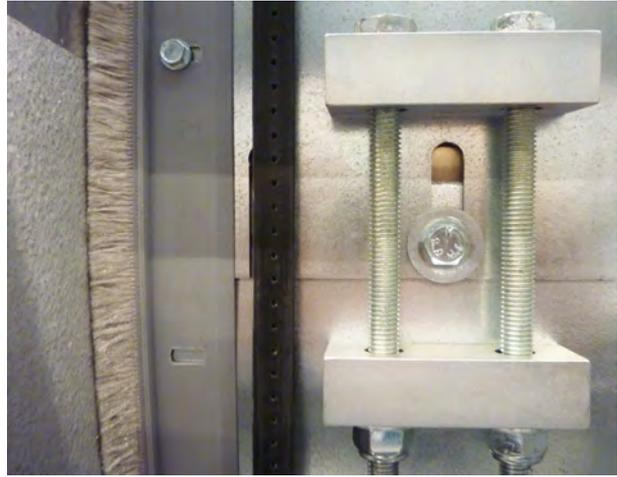
Instale el sensor para registrar la rotación. El sensor debe instalarse a la derecha si miramos desde el lado de inspección de la unidad. Comprobar que la colisión entre sensor y soportes del rotor sea imposible. Ajustar la posición del sensor si es necesario.
