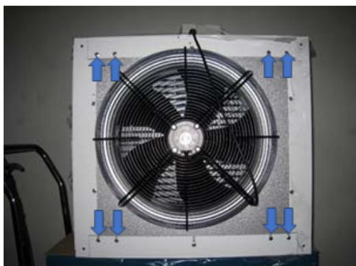
2. Installez les consoles murales avec les trous orientés vers l'aérotherme. Voir le marquage sur la Fig. B. Ces trous permettent de faire passer un collier de serrage pour immobiliser le câble du moteur de l'aérotherme.
