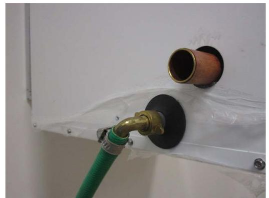
8. L'évacuation des condensats est équipée d'un raccordement G1/2" ; voir la Fig. I. Si la purge est raccordée au système d'évacuation au sol par un flexible, aucun joint d'étanchéité à l'eau n'est nécessaire. Si l'évacuation des condensats est raccordée directement au système de purge, un joint d'étanchéité à l'eau doit être installé afin d'éviter le dégagement de mauvaises odeurs.
