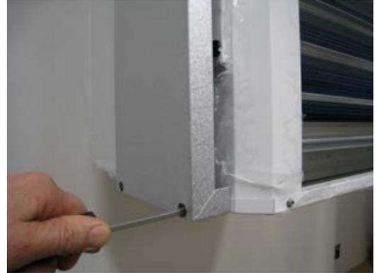
Utilisez un tournevis 1/4" pour desserrer les 4 vis verrouillant la protection de transport ; voir la Fig. D. Retirez la protection de transport, puis remettez les vis en place. Laissez le film de protection sur les pièces de tôle peintes en blanc jusqu'à la fin de l'installation, afin de protéger le métal des rayures et de tout autre dommage.
