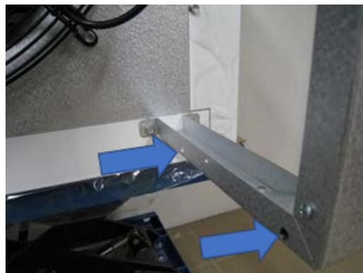
Lors de l'installation de l'aérotherme, la protection de transport des tubes de raccordement située sur le côté gauche ne doit pas être retirée. Assurez-vous que l'appareil est bien horizontal en largeur et en profondeur ; voir les flèches sur la Fig. C.
