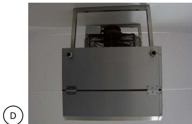
5. Installare il termoventilatore come illustrato nella figura D, in caso di montaggio a soffitto per un flusso d'aria verticale, la distanza minima da rispettare dalla parete è 700 mm. Nel caso in cui il termoventilatore sia montato a soffitto, vicino a un angolo, la distanza minima da una delle pareti deve essere 700 mm e 2000 mm dall'altra. Assicurarsi che il soffitto sia in grado di supportare il peso del termoventilatore.
