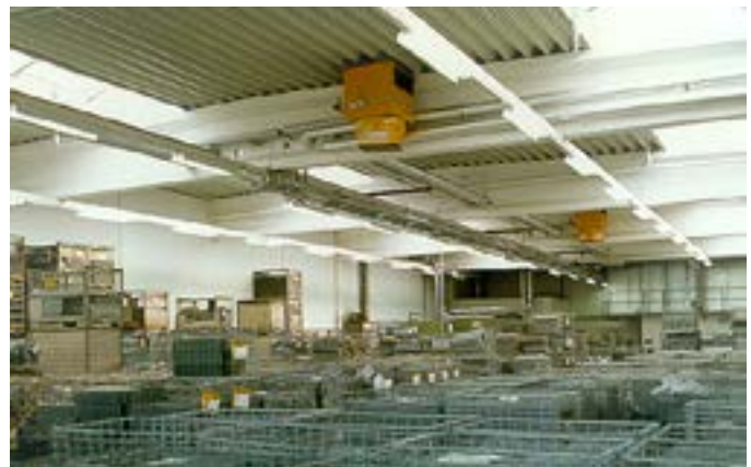
Packhalle mit RotaVent® DD - Deckenlufferheizern
