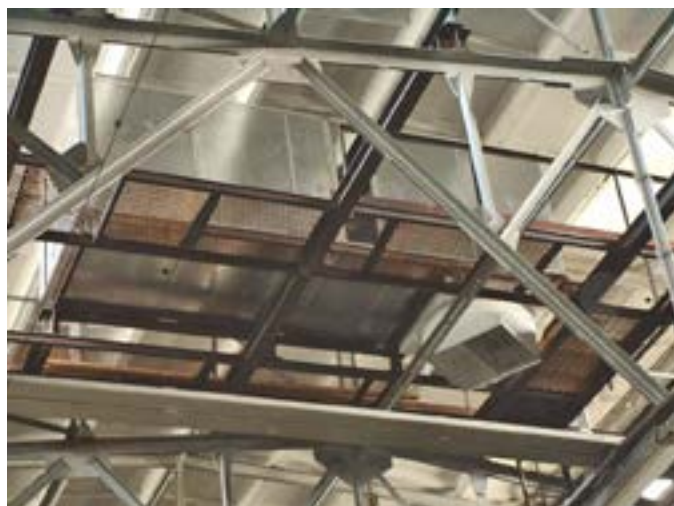
Drehdüse RotaVent® R-HW in Verbindung mit Lüftungszentralgerät
