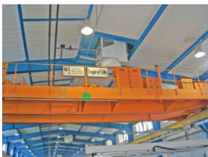
Drehdüse RotaVent® R-HW in Verbindung mit Roofvent® DWR
